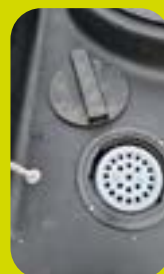
Préfiltre à brosse Sortie décanteur primaire
