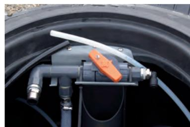
**16** Reconnecter les 2 tuyaux d'air Ø 10 mm et Ø 14 mm. Vérifier que les tuyaux ne soient pas pincés.
