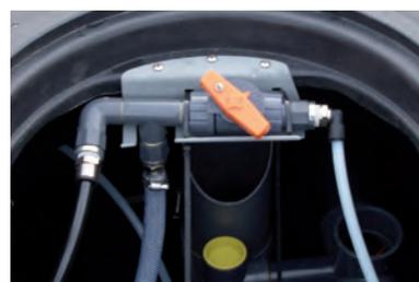
**17** Fixer la console à l'endroit souhaité. Adapter le système de fixation de la console au support mural. Attention, la longueur de 20 ml de tuyau Crystal armé Ø 15 mm ne doit pas être rallongée. Fixer le boîtier 80 x 80 sous la platine.
