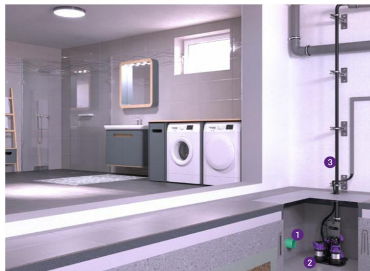
1 Raccordement de l'arrivée 2 Retrolit S 3 Conduites de refoulement
