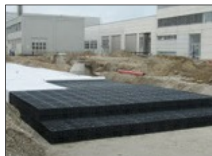
Bâtiment industriel, Schwertberg (Autriche)
