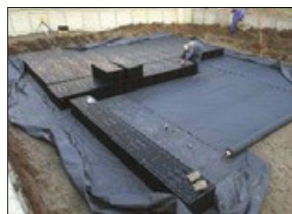
Bâtiment industriel, Warnsveld (Pays-Bas)
