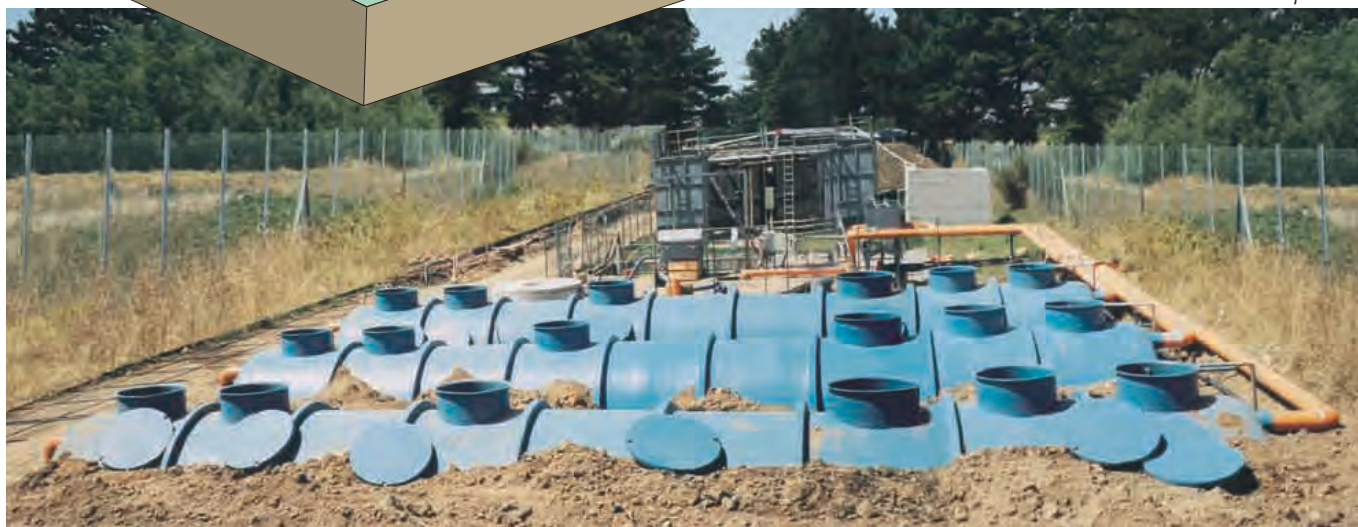
Mise en oeuvre d'une station d'épuration
